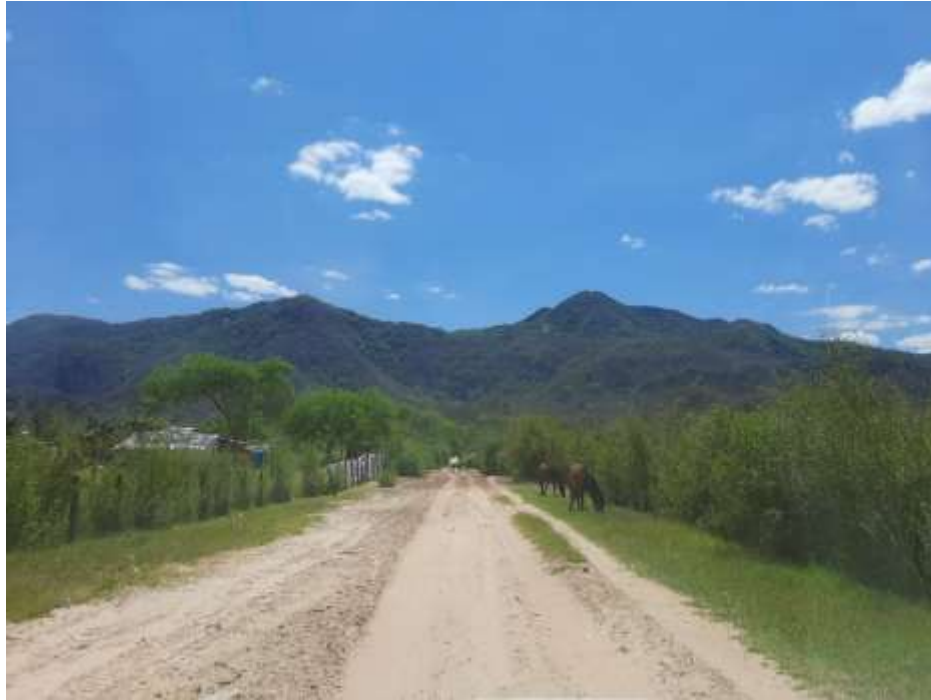
Fotografía N° 12 camino cercano al botadero la Pista, municipio de Lagunillas, tipo de material suelo areno arcilloso.
