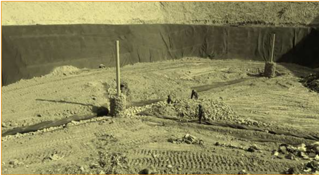
Figura 25 Ejemplo de la instalación de chimeneas
