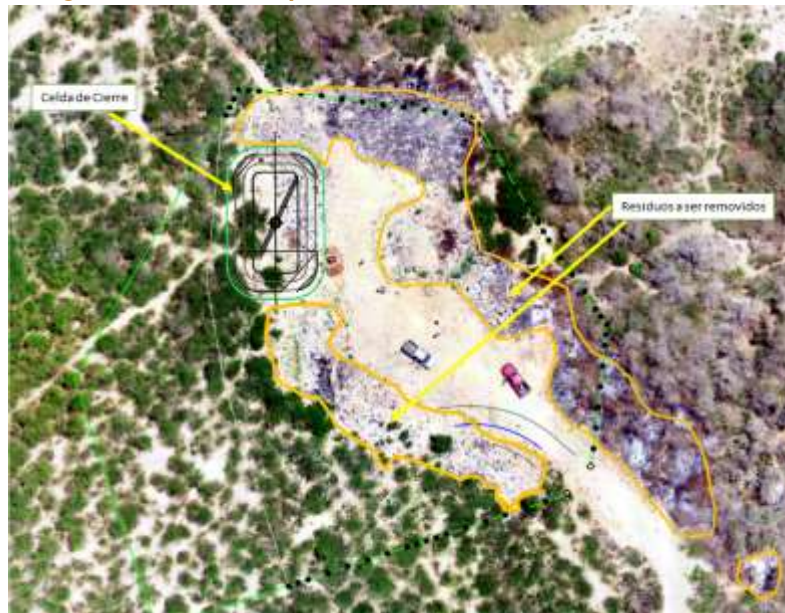
Imagen 6. Residuos que serán reubicados en la celda de cierre
