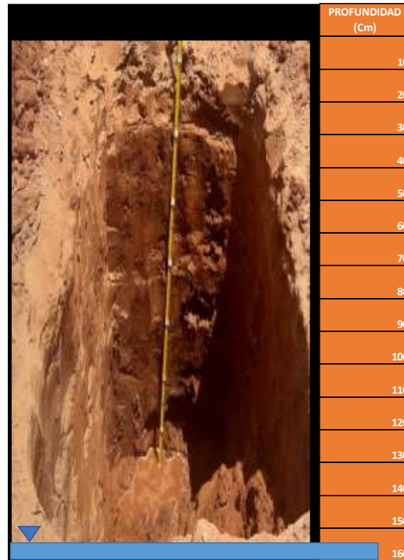
Figura 2 Calicata de exploración de nivel freático
